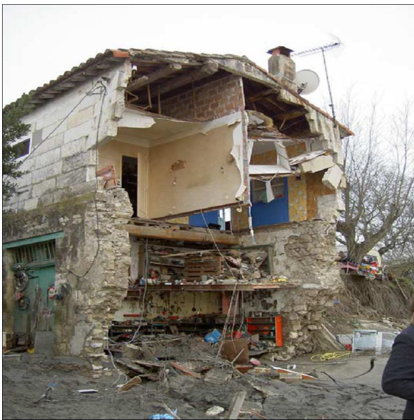
Exemples de dégâts provoqués par des ruptures d'ouvrage : Maison du garde-digue à Fouques en décembre 2003 (à gauche) Rupture de l'Epi de Basse Plaine à la Roque d'Anthéron lors de la crue de janvier 1994 (à droite)
